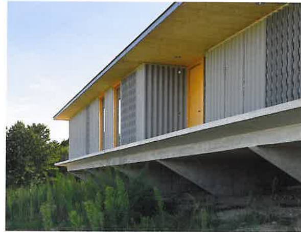
Nordostfassade mit perforiertem Eternit
